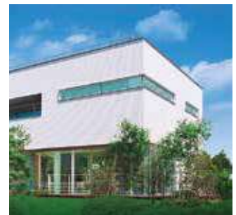
«Умный дом» Ариаке, Токио HVAC и комбинация генераторов солнечной энергии, батарей и аккумуляторов
