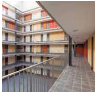
Новый 84-квартирный жилой дом Барселона, Испания Aquaqua
