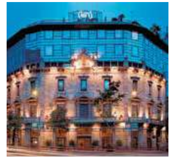
Переоборудование отеля Hotel Claris 5* Барселона, Испания ECOi
